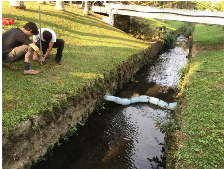
Figura 47 – Colocação de barreira de resíduos no córrego
