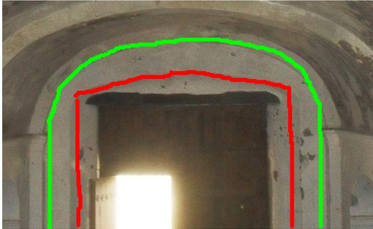
**Cubierta de la sala 24: en rojo, diseño original del s. XVII de cubierta a doble vertiente; en verde, trazado neoclásico del s. XVIII.**
