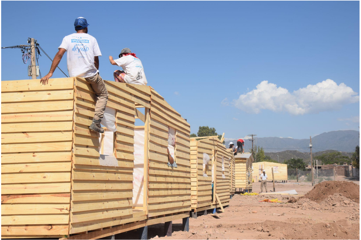
Jornada de construcción - Cuarto día colocación de tirantería de techo
