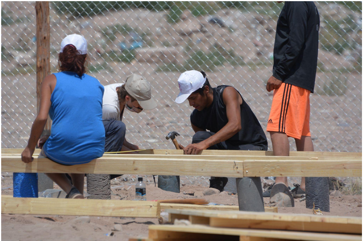
Jornada de construcción - Segundo día colocación de vigas de piso
