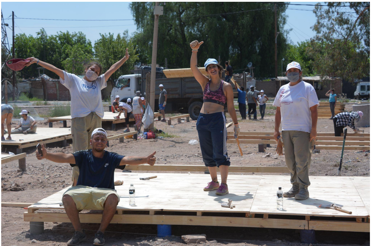
Jornada de construcción - Segundo día colocación de pisos
