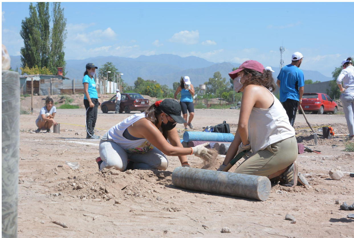
Jornada de construcción- primer día colocación de pilotes
