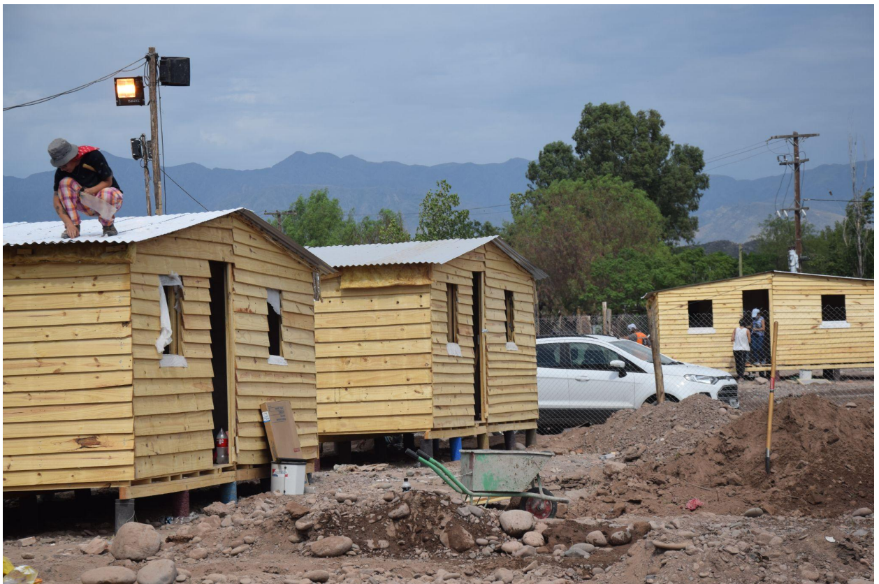
Jornada de Construcción- Cuarto día montaje de techo
