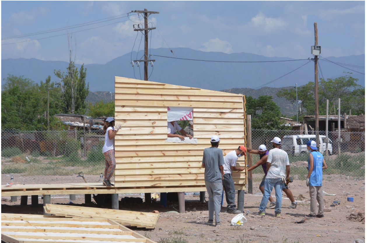
Jornada de construcción- tercer día montaje de paneleria
