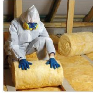
Görsel 4.25: Çatı içi cam yünü uygulaması
