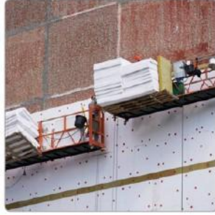
Görsel 4.24: Dış cephe strafor uygulaması
