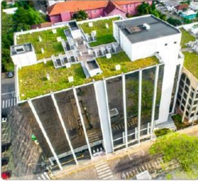
Çatısı toprakla kaplanmış betonarme bina
