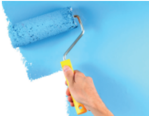
Рис. 1.2. Нанесення фарби малярним валиком
