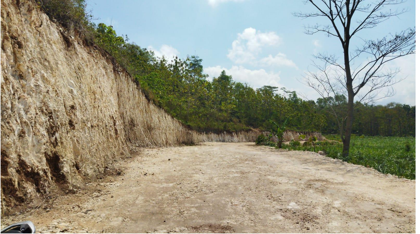
FOTO LOKASI KEGIATAN PEMBANGUNAN COR RABAT JALAN TELAGA SEMPU
