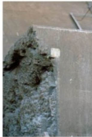
Foto Nº 5 Daños por cavitación en la presa de Salto Grande.
