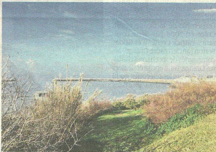
Le port de plaisance de Châtelaillon en hivernage. PHOTO A. M.
