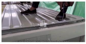
屋根を被せます。屋根の耳の部分を雨樋に打ち付けます。この時茶色のスポンジテープのところに打ちます。 2cmのパッキン付きのビス
