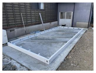
②下の長い鋼材と短い鋼材を取り付けます。取り付けつ時は黒いボルト、ナットを使います。
