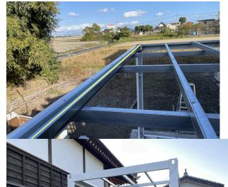
雨樋の屋根を打ち付けるところ(写真黄色)に 茶色のスポンジテープを取り付けます。屋根 の雨水を遮ります。コーキングでも可。 上に上げる前に取り付けると楽です。 動画では両面テープ、ビニールを貼っていま すがスポンジテープに変更されています。
