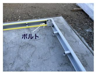
鉄骨の内側にある出っ張りに床が乗ります。床の厚みは18mmなので20mmの耳のある方が上になります。※写真黄色部分
