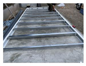
床を載せる軽量鉄骨を取り付けます。 4cm×8cm、8cm×8cmが交互になるように取り付けます。
