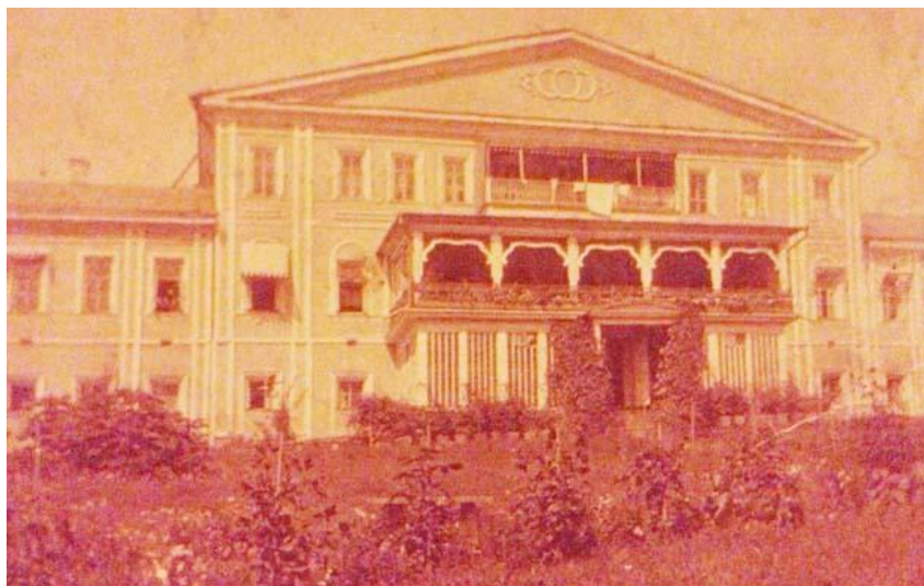
Большой Дом. Вид с южной стороны
