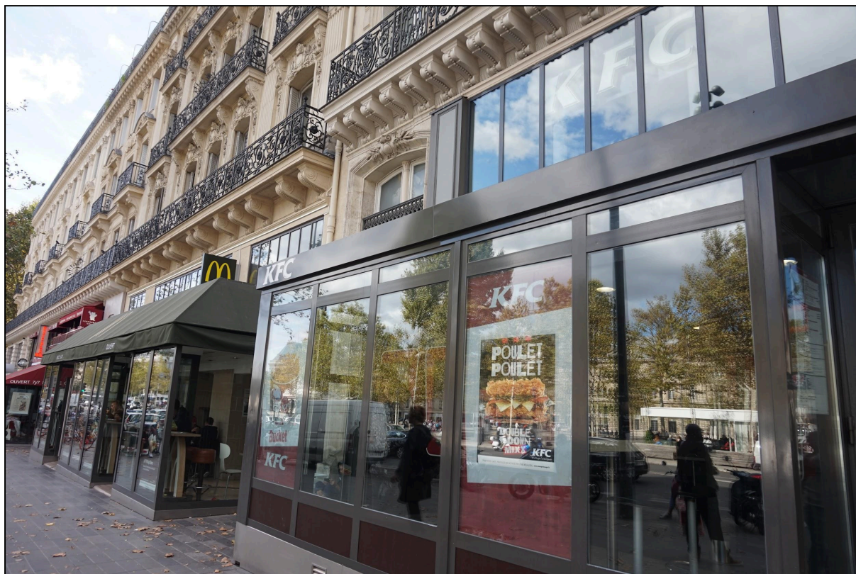
Extérieur des deux établissements enquêtés faisant l'objet de la plainte
