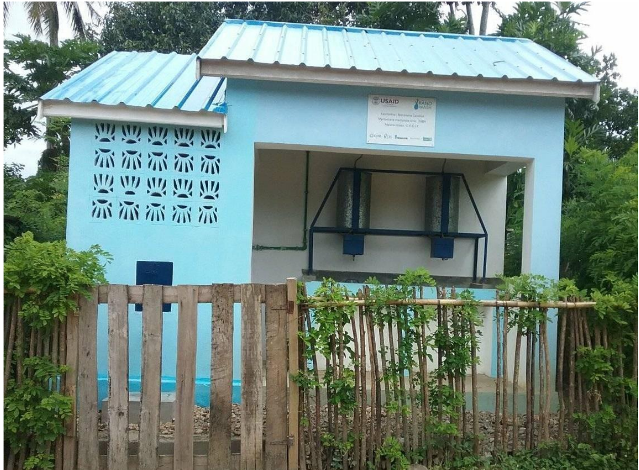
Kiosque à eau automatique Niarovana Caroline
