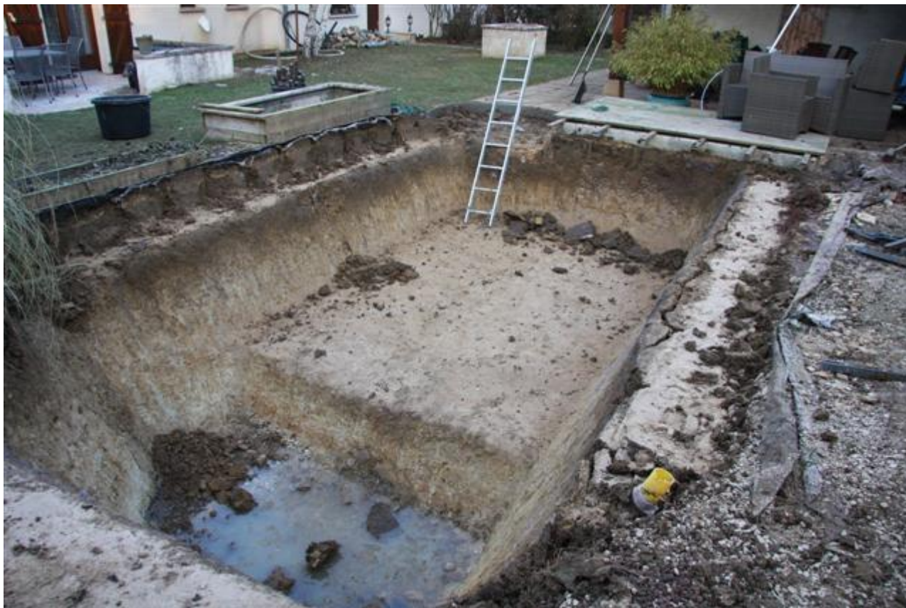
Рисунок 6.16 – Котлован з високим рівнем ґрунтових вод
