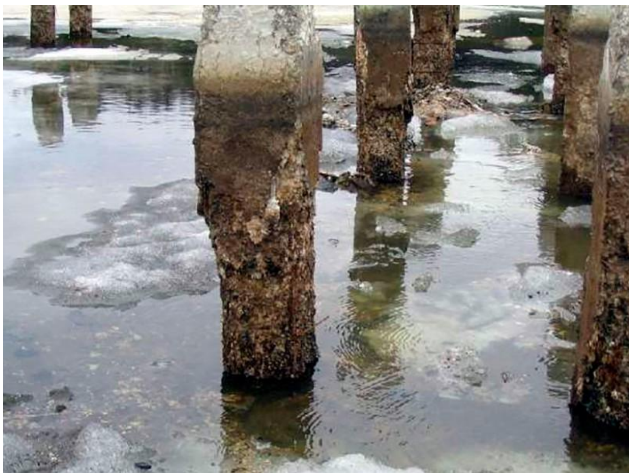
Рисунок 5.2 – Вплив агресивних вод на будівельні конструкції
