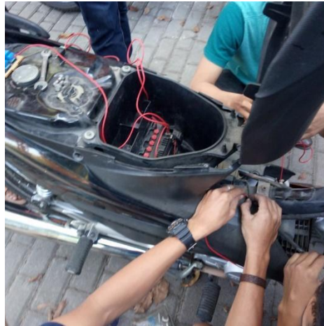
Gambar 1. Pemasangan pengaman di sepeda motor saat praktik kerja di bengkel elektronik Sanjaya
