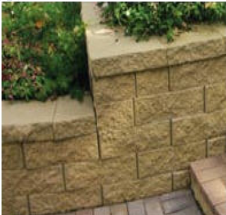
Мурування з бетонних каменів
