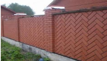
Мурування з керамічної цегли пластичного пресування
