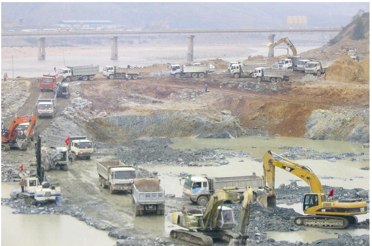
Thiết bị thi công xi măng đất trên công trường dự án đường Cái Mép – Thị Vải
