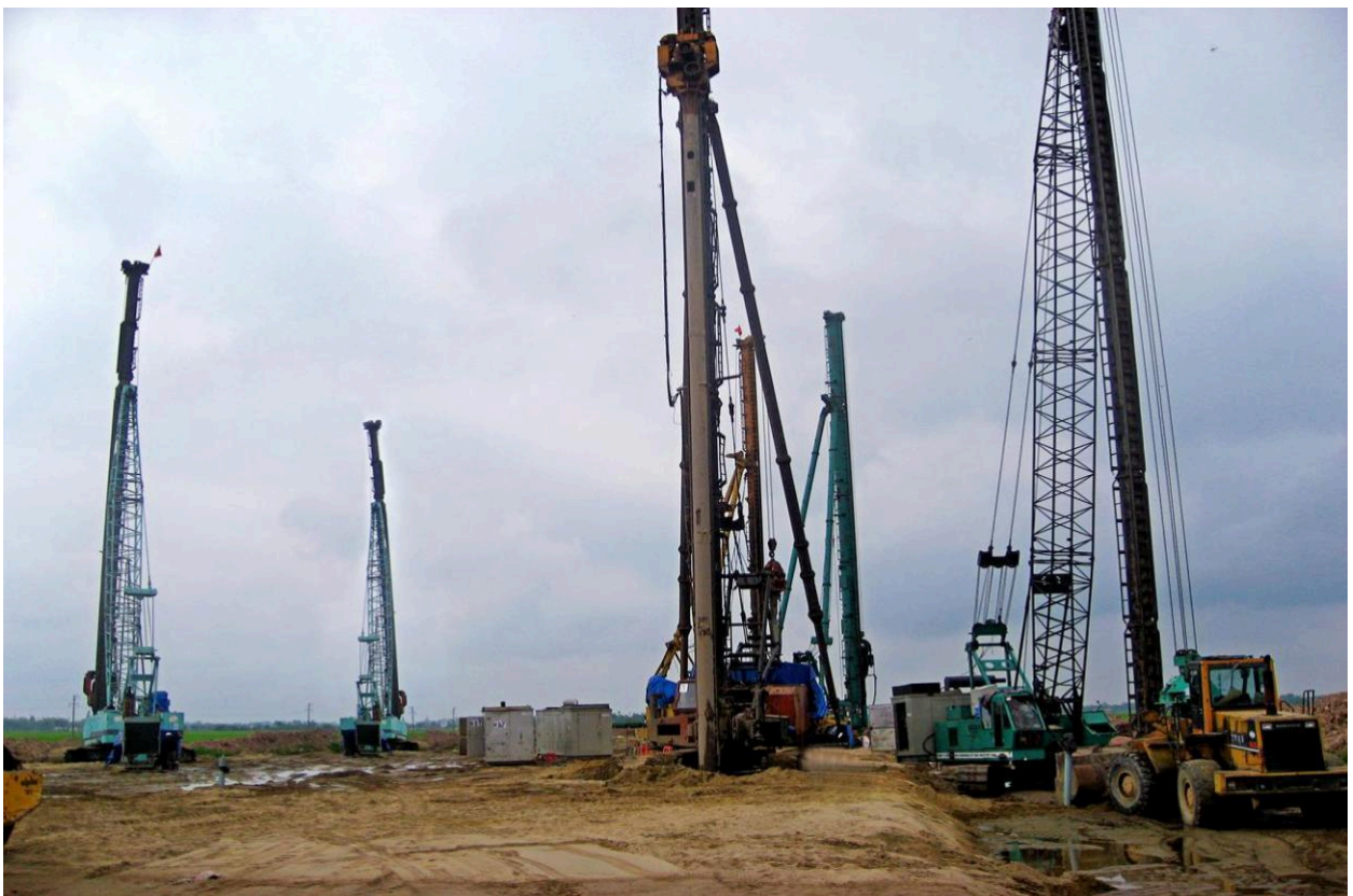
Dự án đường 78 Cambuchia do Tổng công ty thi công
