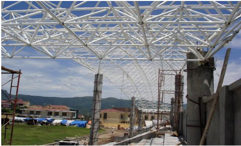
Hình 1.3. Nhà công nghiệp dạng dàn tinh thể.
