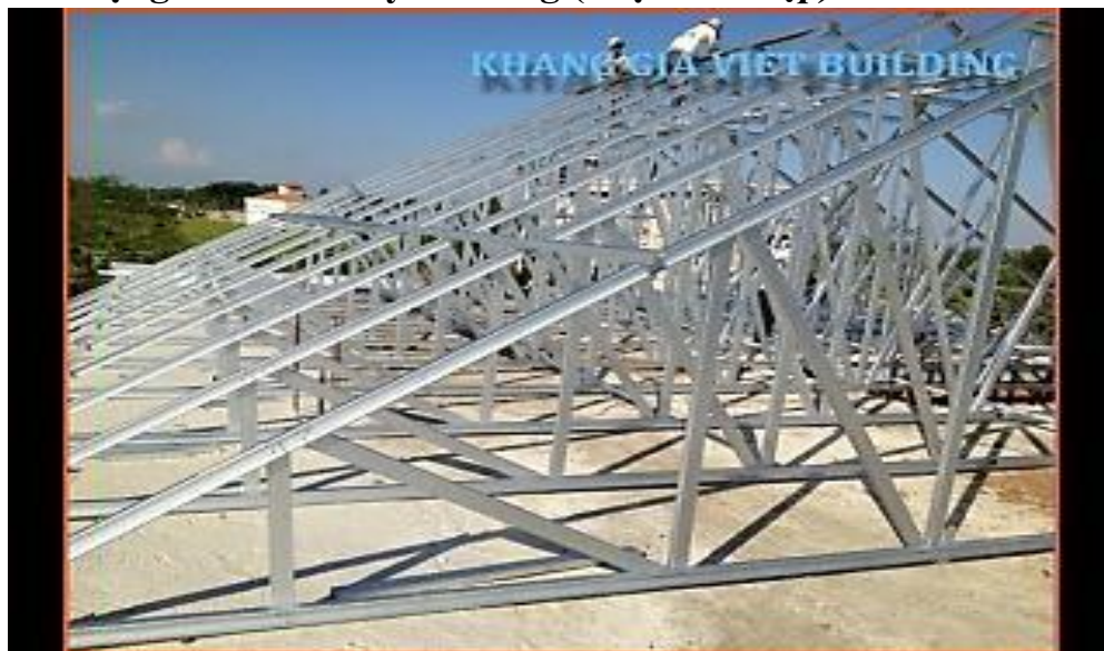
Hình 1.1. Nhà công nghiệp dạng dàn kèo thép.
