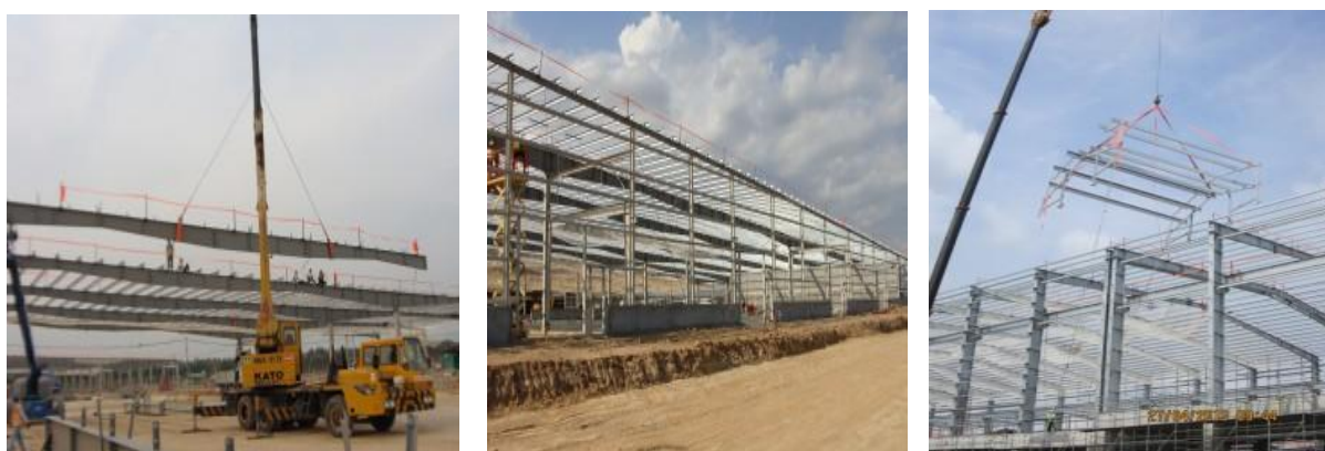
Hình 1.10. Lắp dựng dầm dọc nhà và khung công trời.
