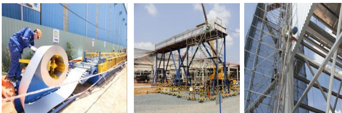
Hình 1.11. Lắp dựng các kết cấu bao che và hoàn thiện.
