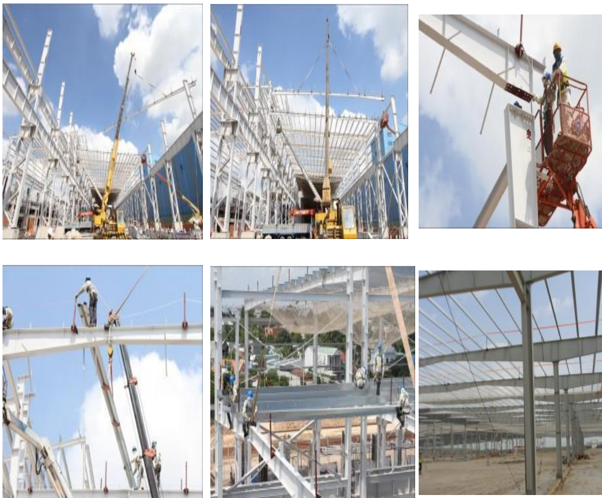
Hình 1.9. Công tác lắp dựng kèo và điều chỉnh khung thép.
