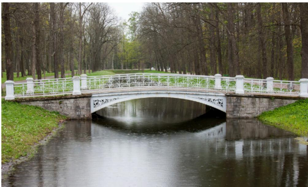
Объемно-пространственное и конструктивное решение однопролетного арочного моста выполнено на металлических клепаных арках, с каменными устоями, с металлическими ограждениями с покрытием по металлическим востеренам.
