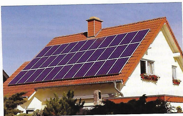
Figura 6.21. Pantallas solares colocadas en el techo de una casa para abastecerla de energía eléctrica
