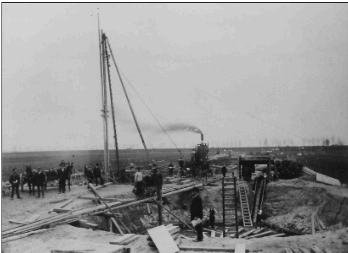
(Afb 14a Culemborg foto maart 1910 De aanleg v/d fundering v/d de watertoren vooraan in het midden met de bouwtekening in de hand de bouwopzichter Jacob Smit Gerritz uit Oud Beijerland (neef van Johannes Smit Fopz))
