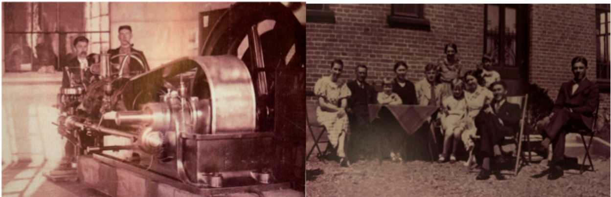
Foto links: Klaas de Braaf (Links) in de machinekamer van de watertoren
