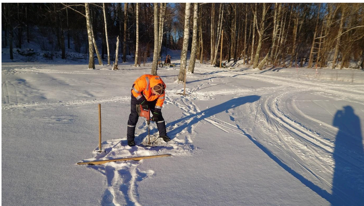
2024-01-16. Här borring i tjälad mark för att slå ner stolpar. Anders Hall på bild.
