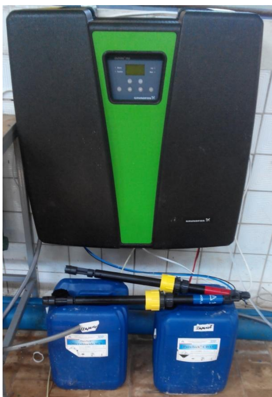
Рис. 2.6. Установа для синтезу діоксиду хлору:
