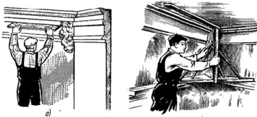
мал. 4. Оброблення кутів лінійкою (а), дотягивание кутовим шаблоном (б) і шаблони напівтертки (в): 1 - для верхньої частини карниза, 2 - для середньої частини карниза, 3 - для нижньої частини карниза
