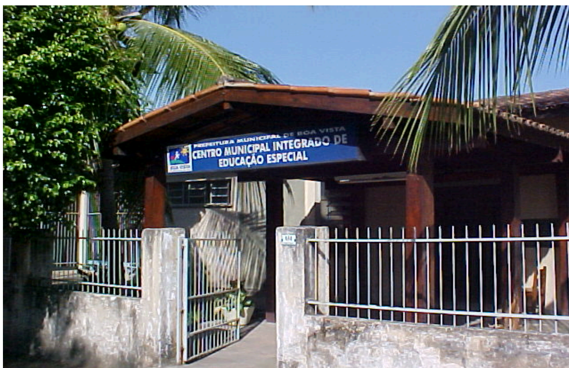
Foto 1 - Fachada do Centro Municipal Integrado de Educação Especial
