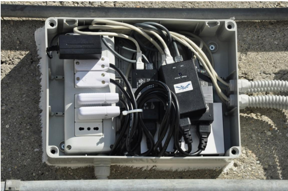
Per quanto riguarda il dressing del cablaggio proveniente dall' abitazione occorre prestare massima attenzione a fissare la guaina in più punti aiutandosi con fascette a strappo e [clips fissatubo a fascetta](#) (gilet) ancorabili con stop.
