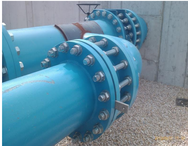
Figura - Requerimientos mínimos de tubería recta para colocar placas orificio
