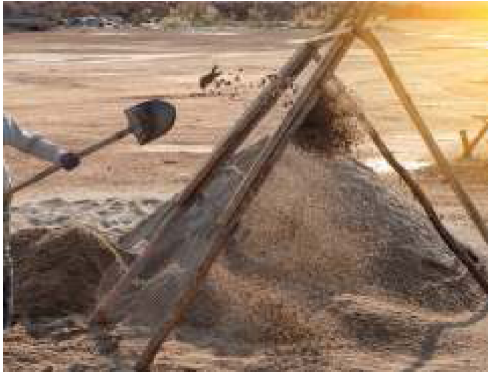
Gambar 5.26 Metode pengayakan yang dilakukan oleh pekerja bangunan.
