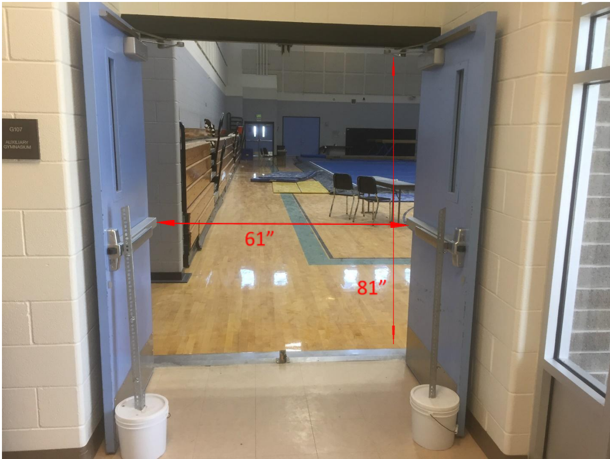
Door #3 – Hallway to Aux. Gym
