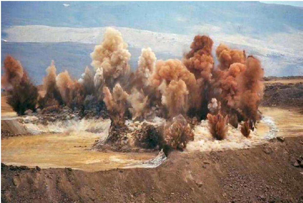
Fotografía N° 09: Para ejecutar las excavaciones se emplearán grandes cantidades de materiales explosivos; en esta fotografía mostramos aproximadamente lo que serían los trabajos con explosivos.
