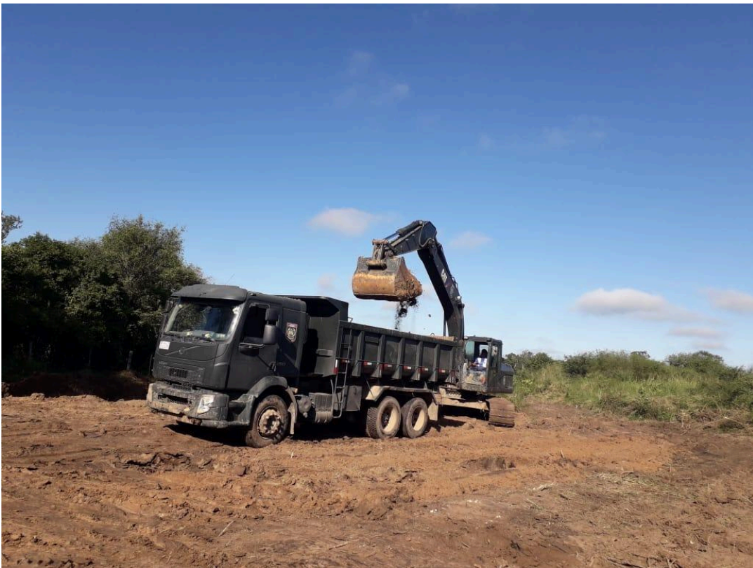
Fotografía 5 - Reparación y conservación de red vial
