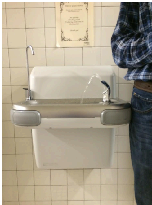
Schramm 5 West Side
