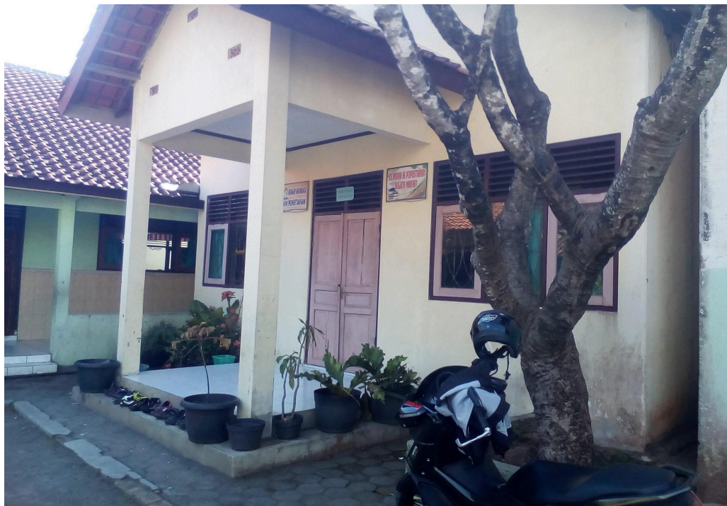
GEDUNG PERPUSTAKAAN SD NEGERI 1 KACANGAN
