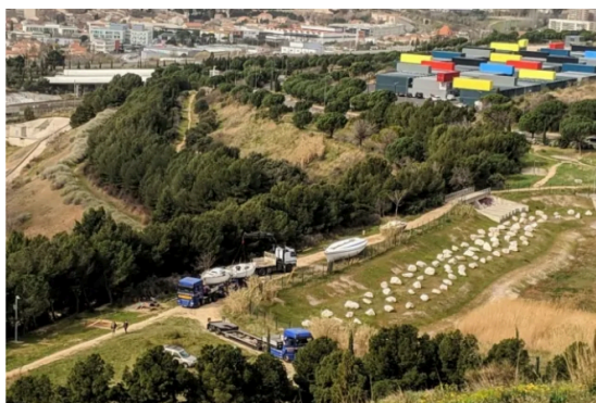
Le parc Foresta se situe à côté du MIF 68 dans les quartiers nord
