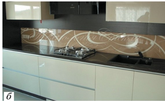
Рис. 8.12. Отделка стен: а — керамической плиткой; б — панелью из стекла
