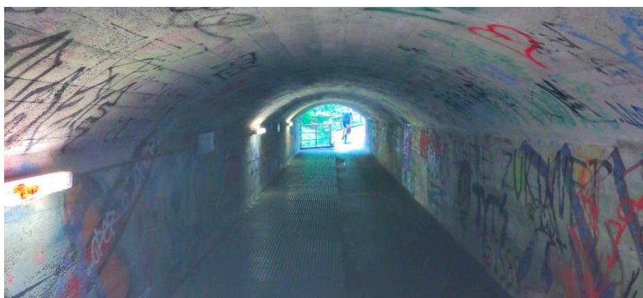
Unterführung Ascherbachstraße unter stillgelegten Bahndamm in Olching
