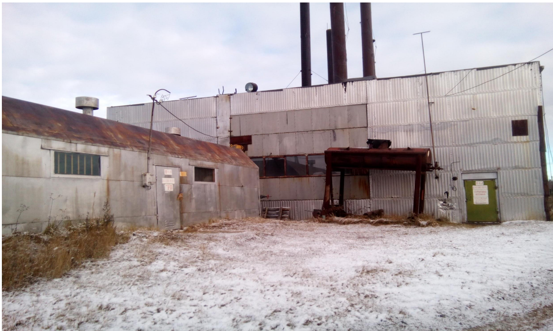
Здание котельной №2, г.п.Иgrim, ул.Лермонтова, 1а
