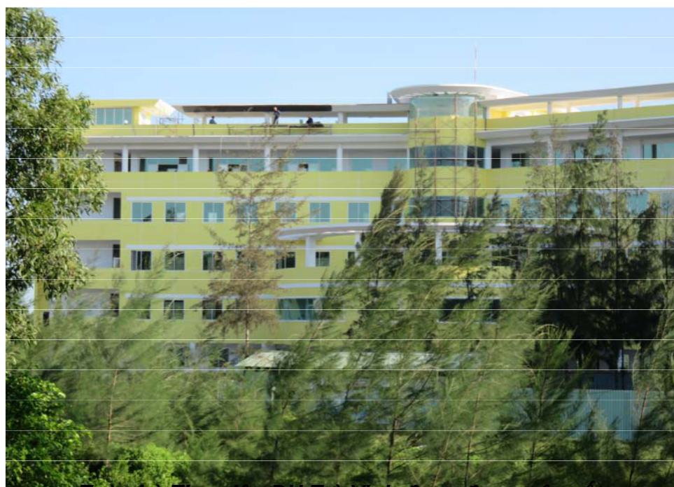
Toà nhà Thư viện ĐH Trà Vinh đang được xây cất, sẽ được sử dụng trong năm 2016
