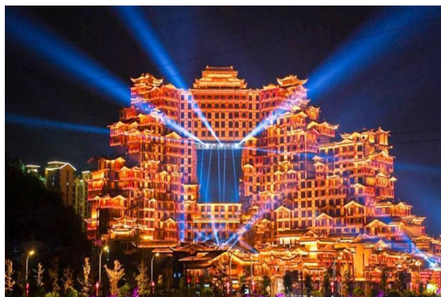
Tòa nhà 72 kỳ lâu
