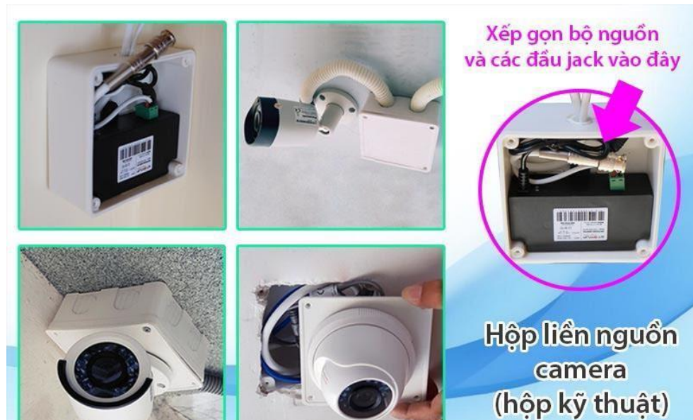
Hình 2.16 Cách lắp đặt hộp nguồn kỹ thuật (hộp liên nguồn) cho camera
