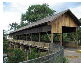
Antônio Bortolon Bridge
