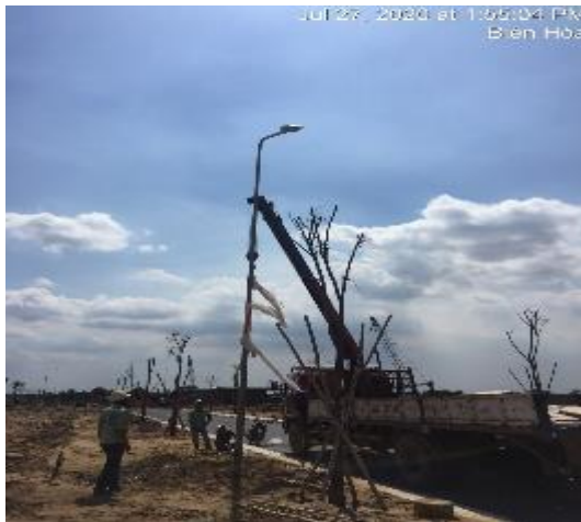
Lắp dựng trụ đèn
