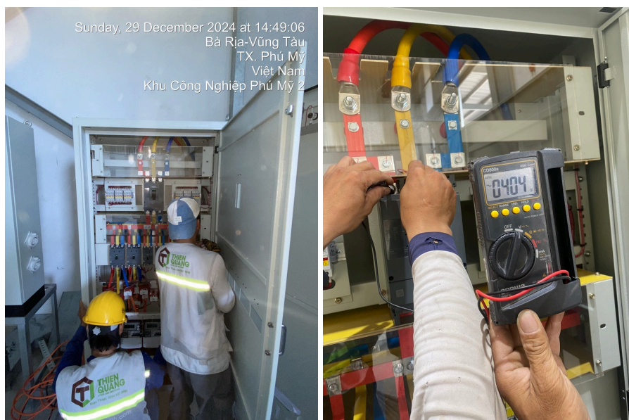
Hình ảnh lắp đặt đấu nối tủ điện
