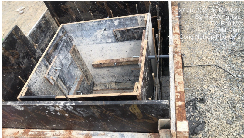
Hình ảnh gia công thép, ván khuôn
