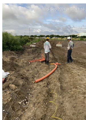
Công tác mồi dây, kéo cáp
