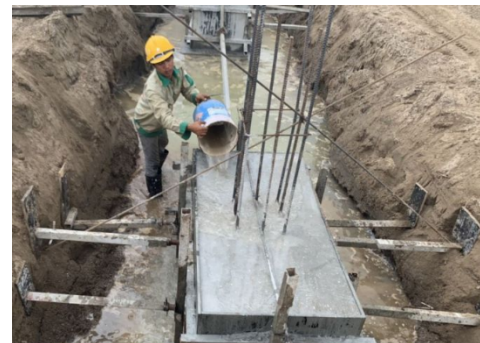
Hình ảnh bảo dưỡng bê tông
