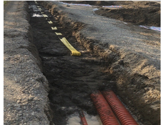
Hình ảnh lắp đặt ống HDPE & băng cảnh báo
