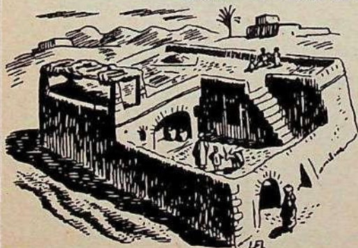
Maison avec son toit en terrasse.
