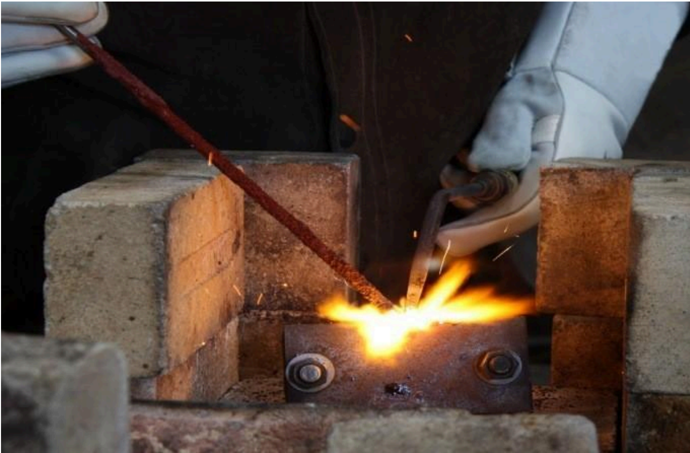
ФОТО з Ремонт чавунного виробу
