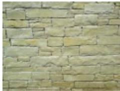
lastre segate : spessori modesti tra i 2-4 cm. Sono utilizzate per rivestimento di muri (in c.a. o laterizio) o di rivestimento di gradini
