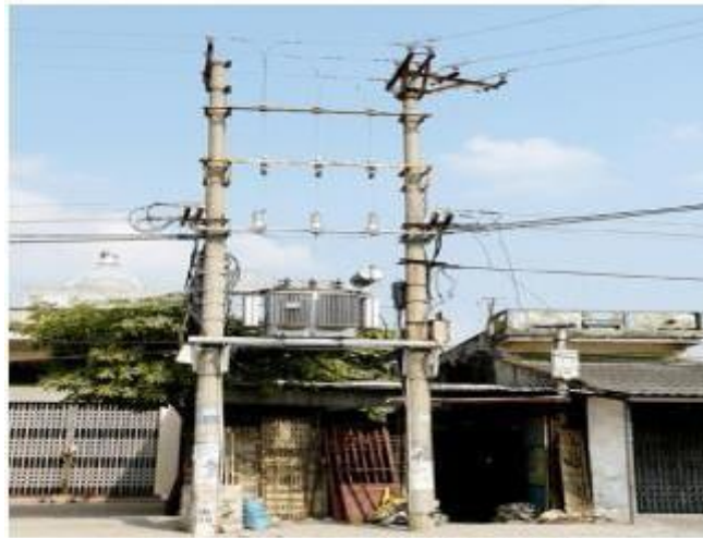
Hình 2-9: Trạm treo S_{dm} \leq 3 \times 75 kVA
