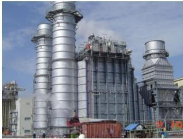
Hình 1. Nhà máy nhiệt điện
