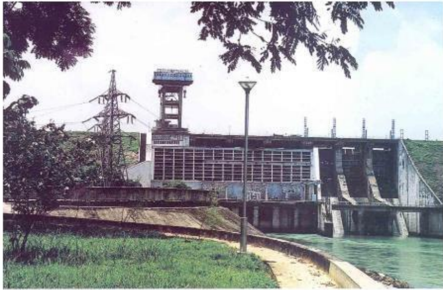
Hình 2. Nhà máy thủy điện
