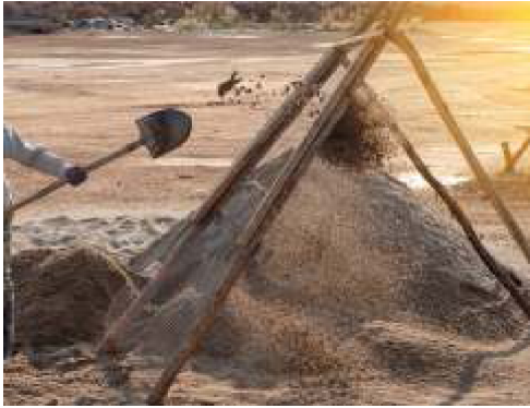
Gambar 5.26 Metode pengayakan yang dilakukan oleh pekerja bangunan.
