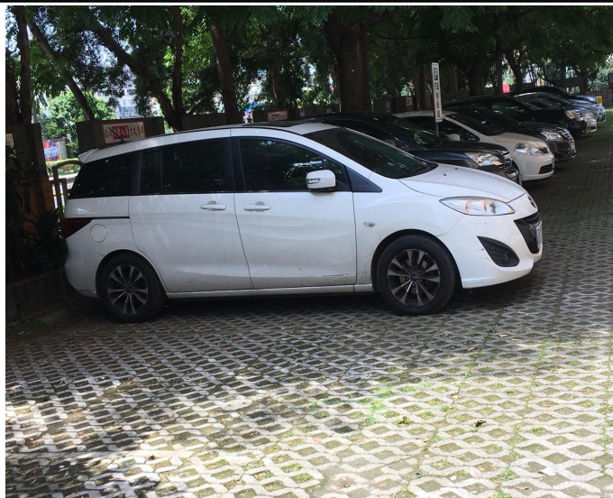
校園設置透水鋪面停車場
