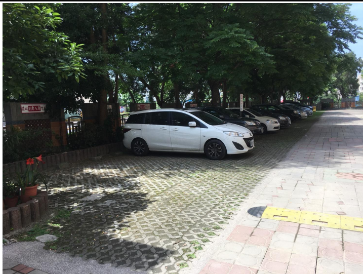
校園設置透水鋪面停車場
