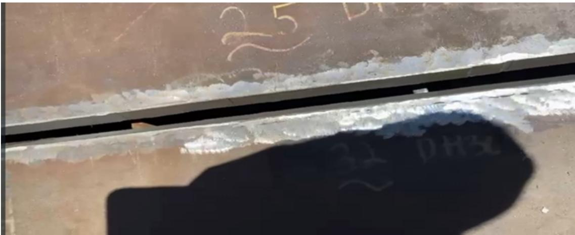
**Gambar 4.6** Area seam join setelah dilakukan pemotongan dan re-bevel
