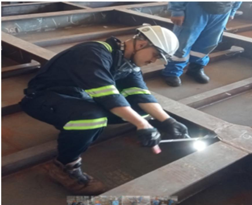
**Gambar 4. 10 Seorang Inspector sedang melakukan inspection pada area yang baru di repair**
