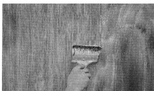
**Растушуем краску** флейцем так равномерно, как это возможно по всей поверхности, предотвращая образование затеков. Если декорируются большие поверхности, рекомендуется работать вдвоем: один наносит краску, другой растушевывает ее.
