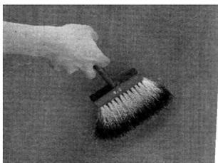
Осторожным **постукиванием щетки** ( узкая плоская кисть- как обойная ) по поверхности образуем точечные наплывы краски, которые позволят затем распределить ее равномерно. Однако при этом фон должен слегка просвечивать, поэтому время от времени давление кисти на поверхность должно ослабевать. Полученный результат создаст эффект чистого голубого неба.
