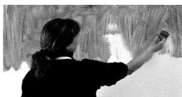
1 *Приготовим лиссеровочную краску* из светло-сине (ультрамариновой с 1 частью льняного масла и 2 частям! бальзама терпентина. Нанесем ее на предварительно -загрунтованную алкидной смоляной краской с шелковистым блеском поверхность, поочередно на участки, равные примерно на 1 кв. м.
