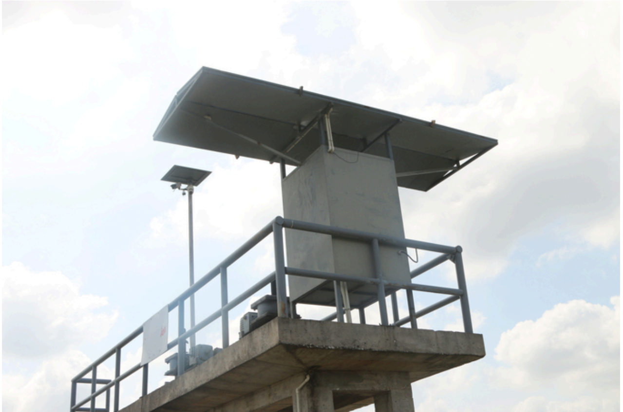
Hình 3: Sử dụng năng lượng mặt trời cung cấp điện cho vận hành đập
