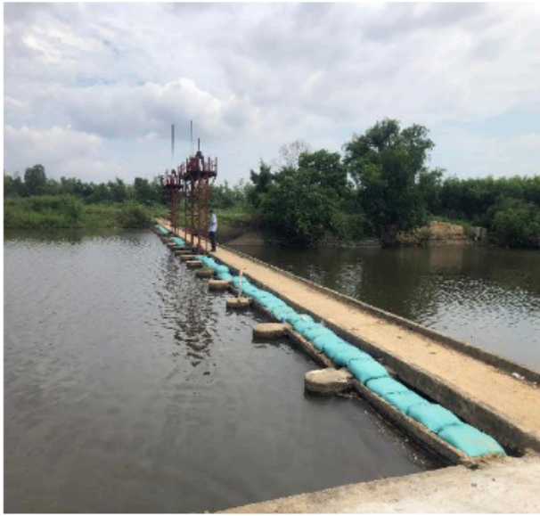
Hình 1: Đập ngăn mặn Cây Dừa đang vận hành đóng mở bằng Palăng kéo tay [1]
