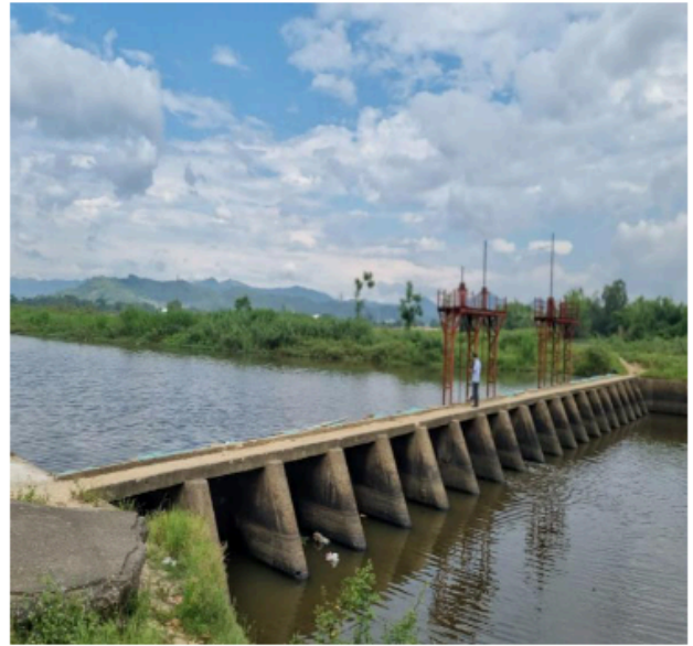
Hình 1: Đập ngăn mặn Cây Dừa đang vận hành đóng mở bằng Palăng kéo tay [1]
